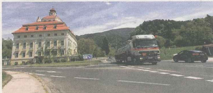
Bei Schloss Pöckstein wird neue vierspurige Straße gebaut HAUTZENBERGER, KLZ
