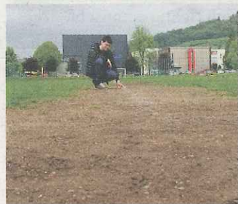
Der Rasen gleicht einem Betonplatz
